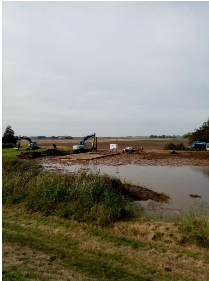
Werkzaamheden Hoogheemraadschap bij mijn netten C en D
